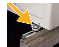
Gummipuffer helfen, den Körperschall zu reduzieren.
